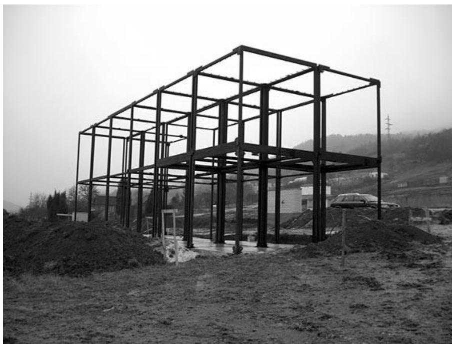
HŠH architekti Családi ház (épülőben) Breoun 2004
