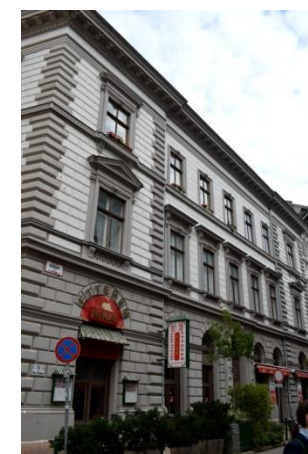
Ráday utca felőli homlokzat
