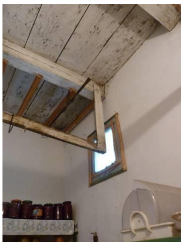
47. kép: Mestergerenda felhúzója (forrás: saját ábra)
