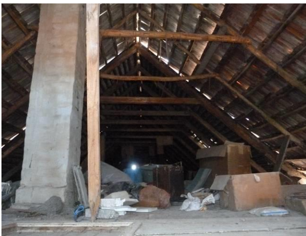
54. A Mayer-ház tetőszerkezetének '60-as években újraépített része (forrás: saját fotó)
