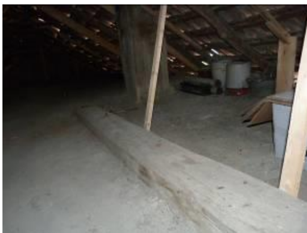
48. kép: Felhúzott mestergerenda a Greksa-ház padlásán (forrás: saját fotó)
