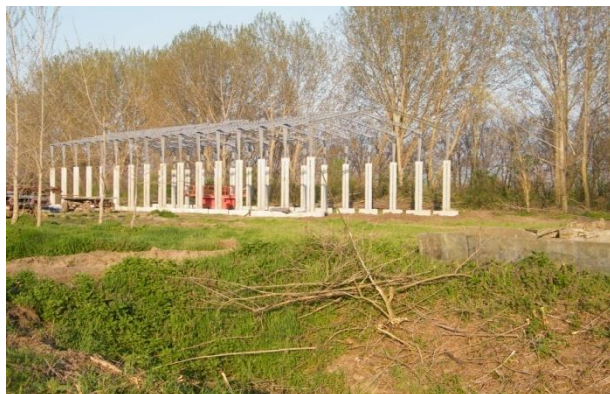
1. kép - Épülő tároló
