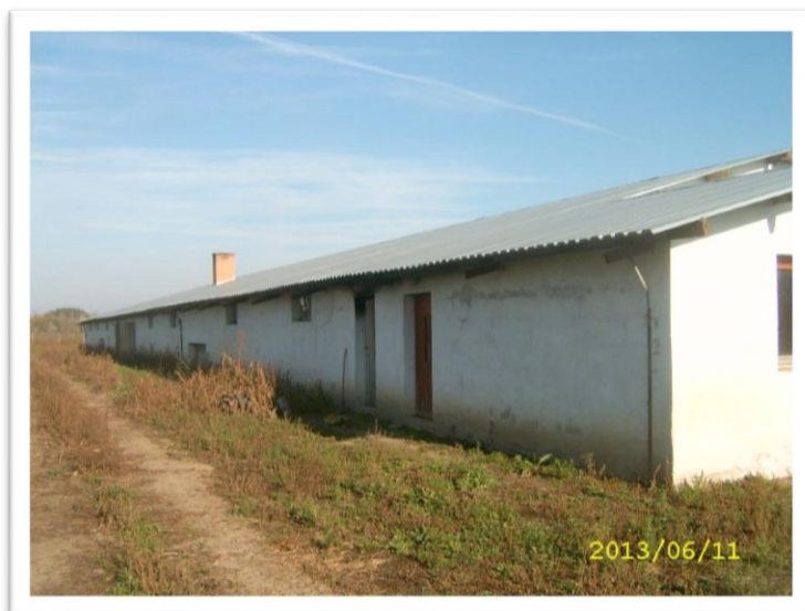
13. kép: "B" istállója Forrás: Saját készítés, 2013
