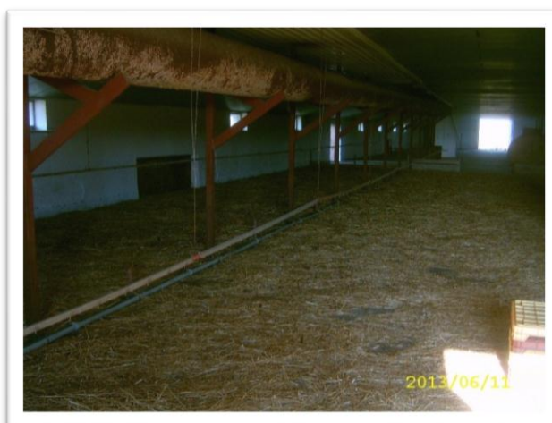
17.kép: A tüzelőanyag (fa) égéshője egy csövön keresztül végigfut az istállón Forrás: Saját készítés, 2013
