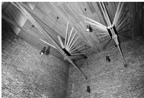
(29) Säynätsalo fedélszerkezetete
