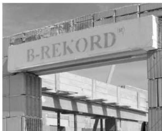
18. ábra: Áthidalóval kombinált falazatra ültetett redőnytök beépítés közbeni állapotában (forrás: baltavariredony.hu)
