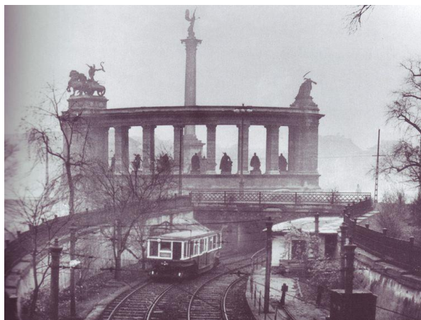
2. ábra: A Milleniumi Földalatti Vasút korábbi felszíni szakasza a Hősök terénél
