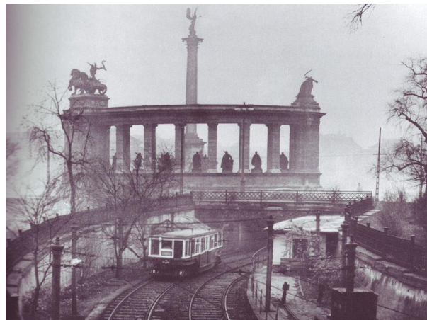
2. ábra: A Milleniumi Földalatti Vasút korábbi felszíni szakasza a Hősök terénél
