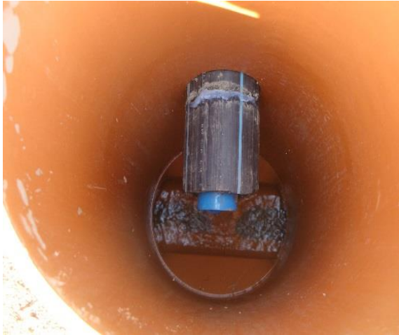
4. kép Drén kivezetése (Forrás: a szerző)
