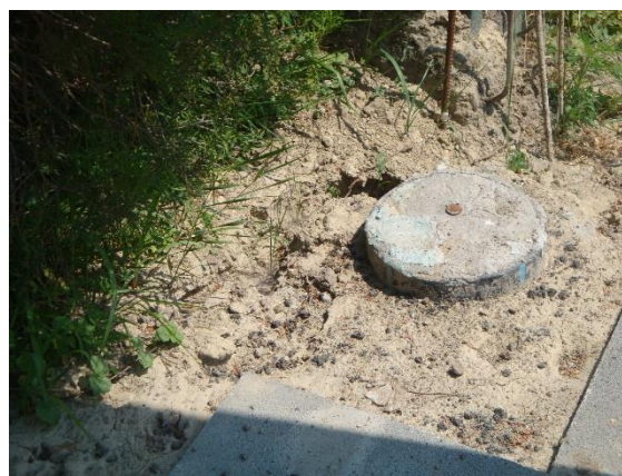
6. kép Az ejtőkutak megjelenő nyoma (Forrás: a szerző)
