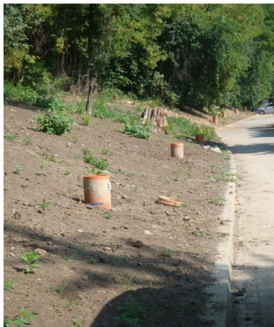
3. kép Drének felszínre bukkonása a Harcsa utcában (Forrás: a szerző)
