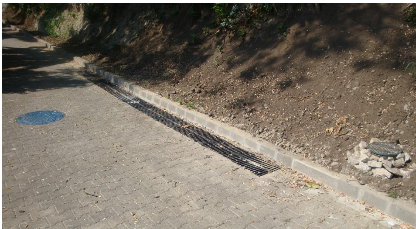
7. kép Vápas vízelvezető a Harcsa utcában (Forrás: a szerző)
