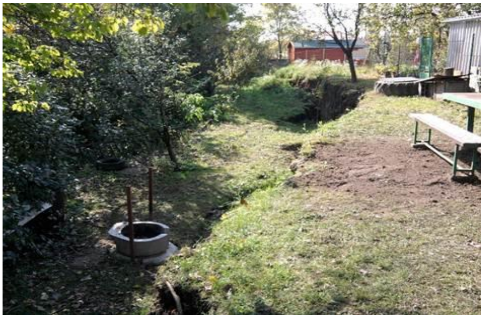
9. kép Ivó utcával párhuzamos szakadás 1/1 (2010-10-13) (Forrás: Sycons Kft.)
