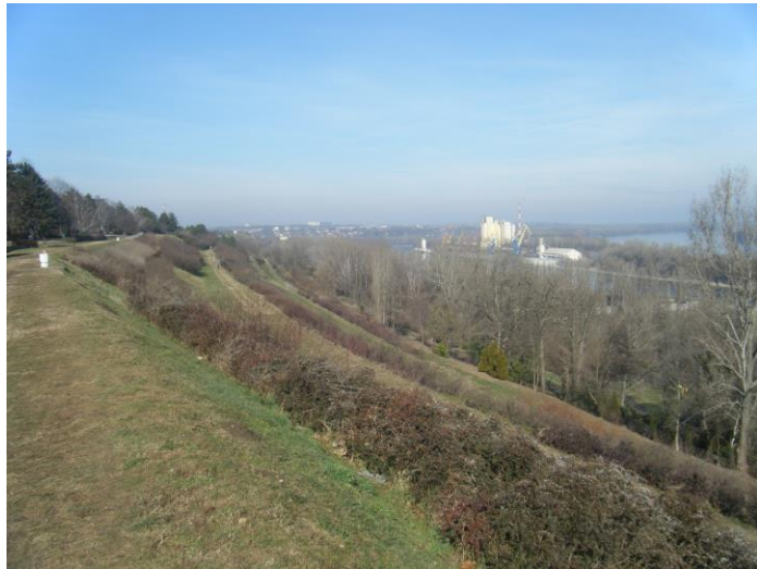
2. kép A rézsűszerűen kialakított tereplépcsők
