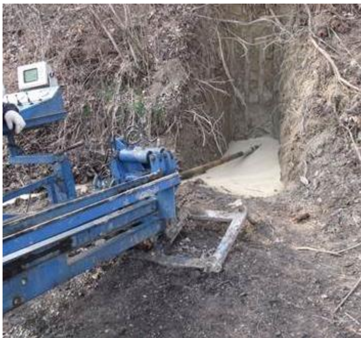
5. kép Mélyszivárgó drének sajtolása (Forrás: Sycons Kft.)
