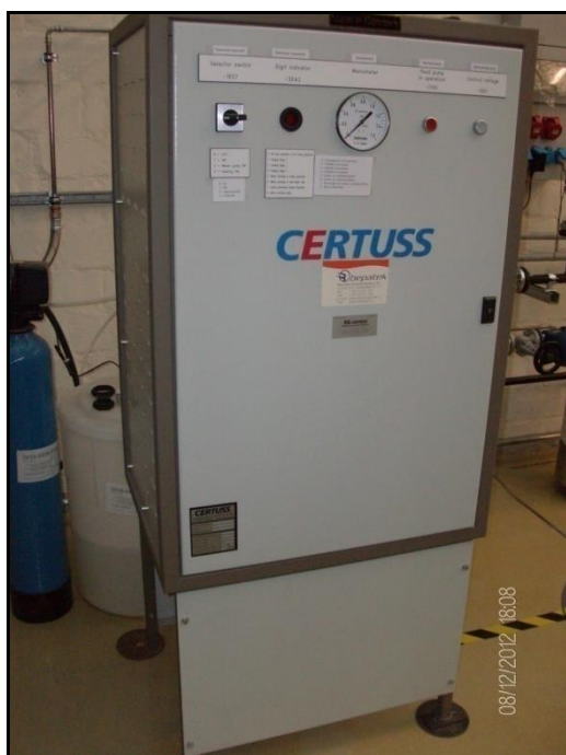
11. ábra A gőz előállítás – A kazán (fénykép)
