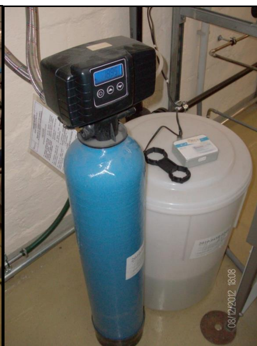
12. ábra A víz lágyító berendezés (fénykép)
