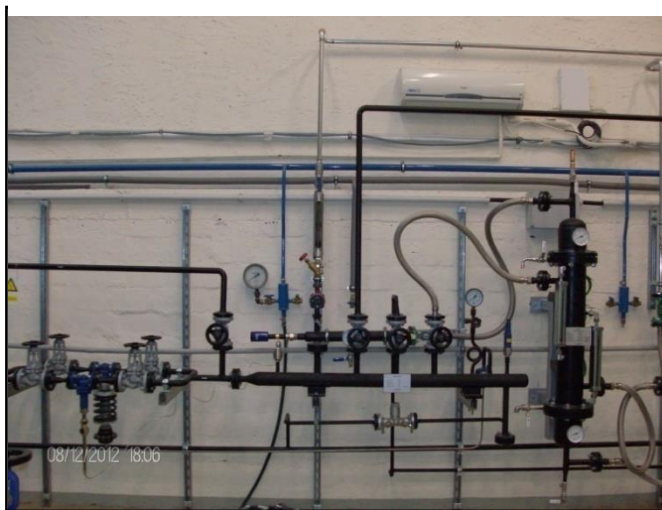
20. ábra A gőzosztó (fénykép)
