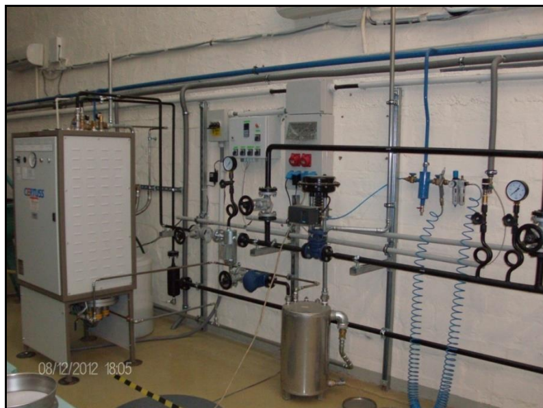
8. ábra A gőz előállítása és előszabályozása (rajz)
