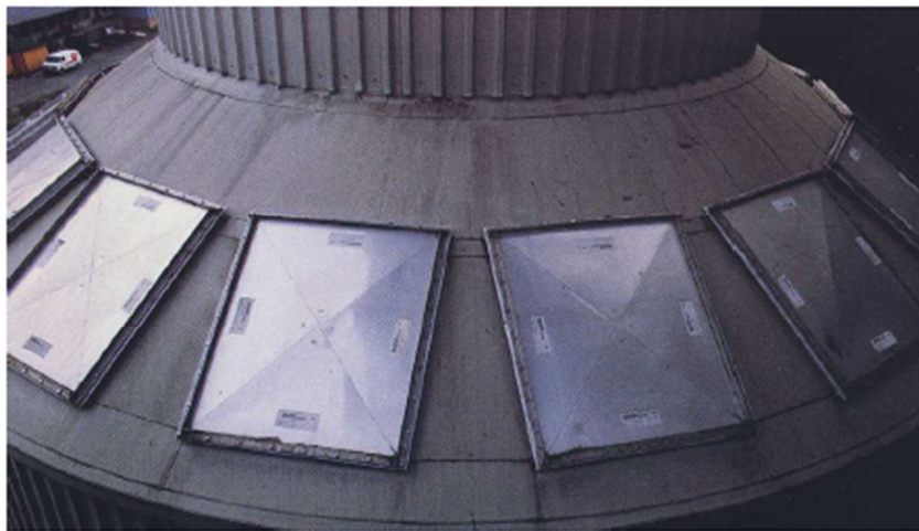
1-2. ábra Cukortároló védelme hasadó panelekkel
