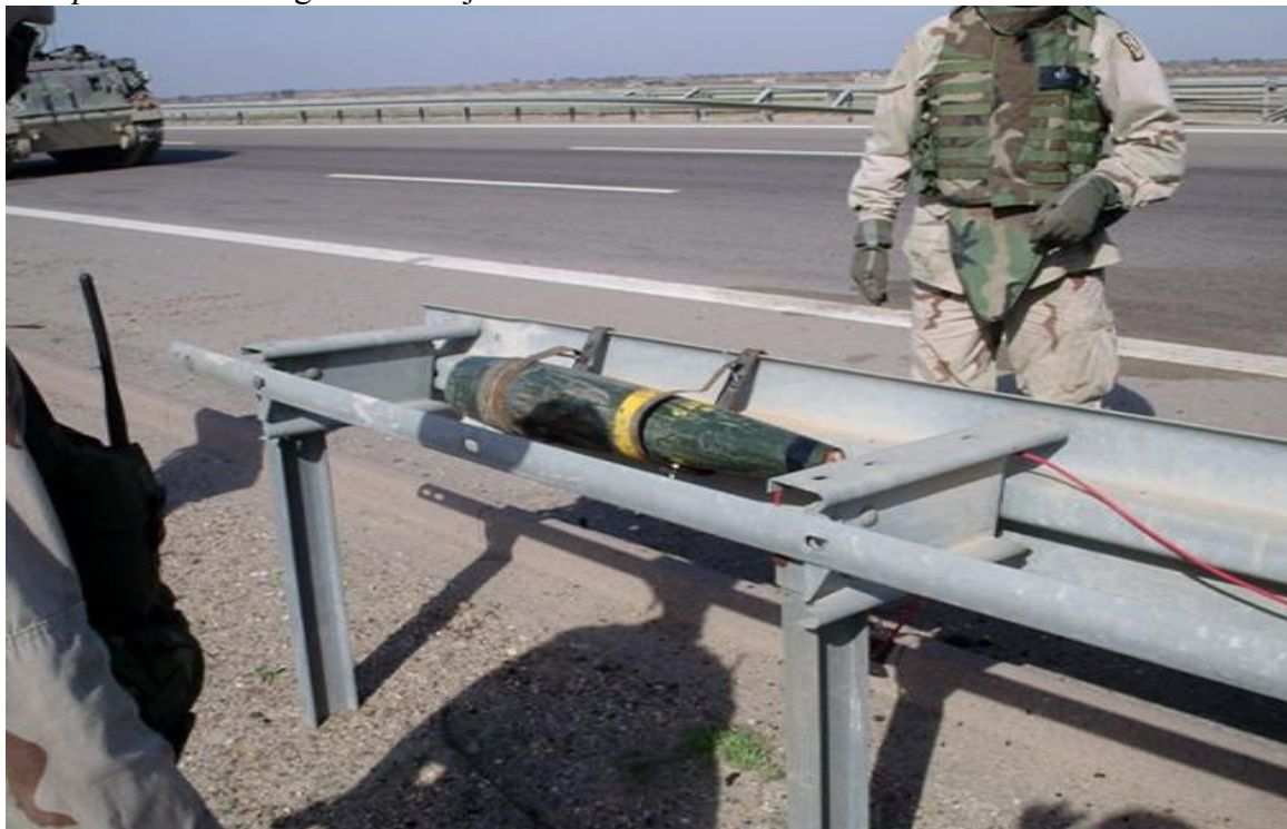
1. kép: Útszéli szalagkorlátba rejtett IED
