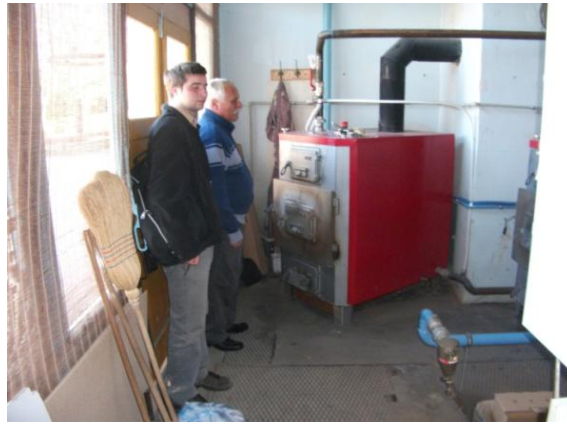
1. kép: Terepbejárásaink egyike: Molnár Imre Zoltán, a békésszentandrási általános iskola igazgatója mutatja be a saját ötlete alapján alkalmazott szalmatüzelésű kazán működését.
