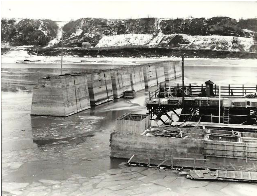
13. ábra Az épülő kikötő (forrás: http://kisonilaszlo.hu/?modul=galeria&a=98410&p=3 )
