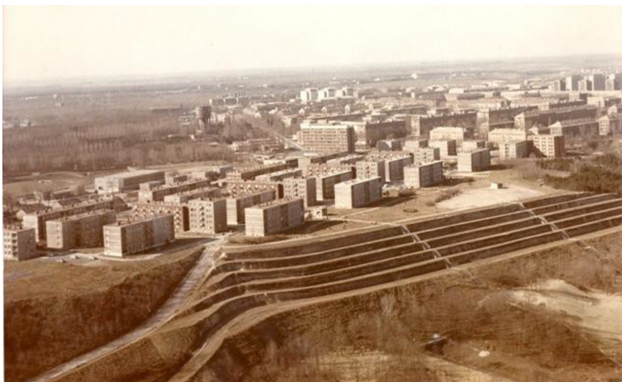
6. ábra Barátság városrész alatt kialakított partvédelmi mű (forrás: http://img2.lapunk.hu/tarhely/technikum-kismon/galeria/775203.png )
