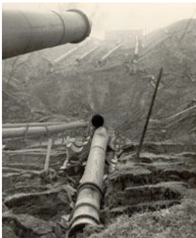
18. ábra 1964. II. 29. Szivattyúház elszakadt vezetékei (forrás: http://www.partvedelem.hu/visszatekinto.htm )
