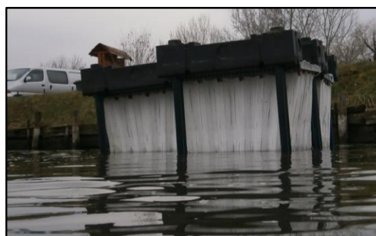
2. ábra: Úszó modul és mesterséges biofilmhordozó, 2013 (Organica Technológiák Zrt.)
