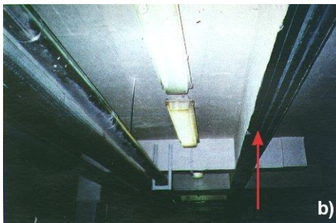
18. ábra Kivitelezés után (piros nyíllal jelölve a hiányzó oszlop helye)
