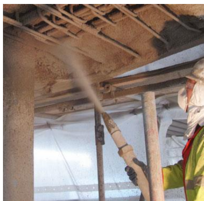
29. ábra Lőttbeton alkalmazása sérült vasbeton szerkezetről
