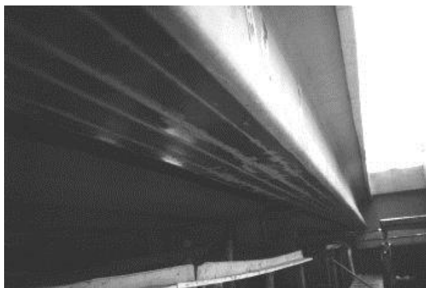
21. ábra A hídgerenda a megerősítés után
