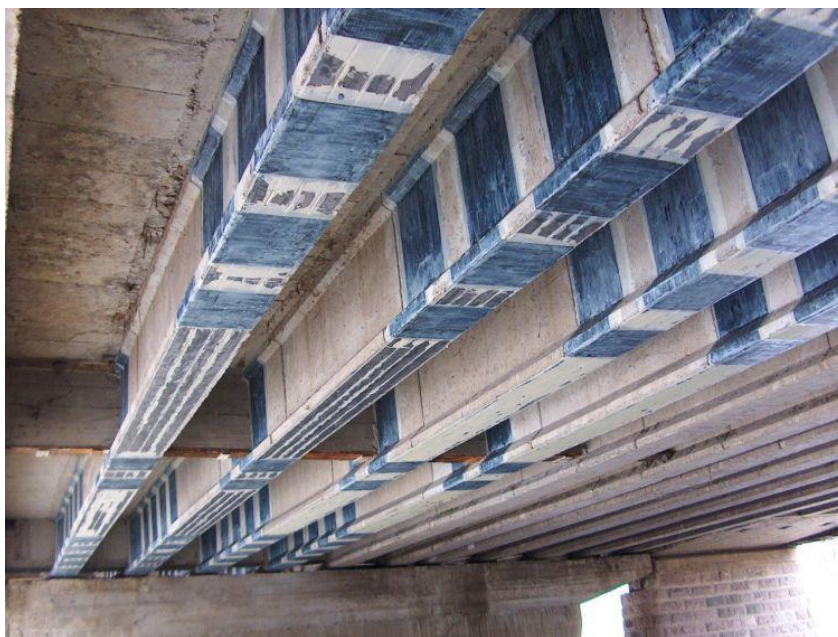
25. ábra A megerősített főtartók
