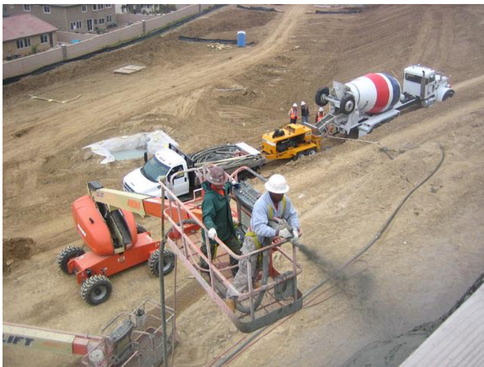
30. ábra Lövellt beton géplánc alkalmazás közben
