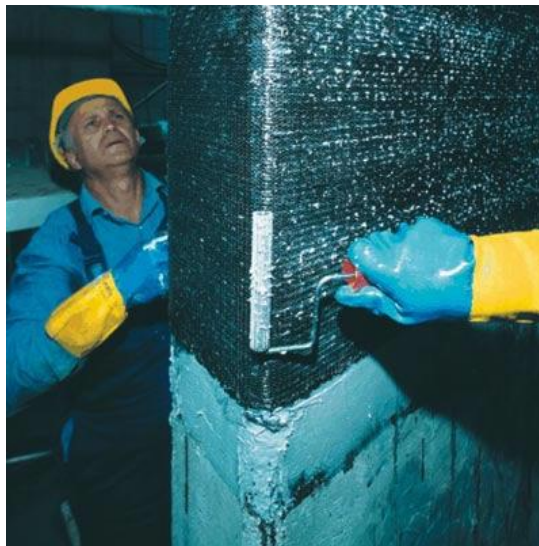
15. ábra Száraz rendszerű impregnálóanyag felhordása a szövetrétegre
