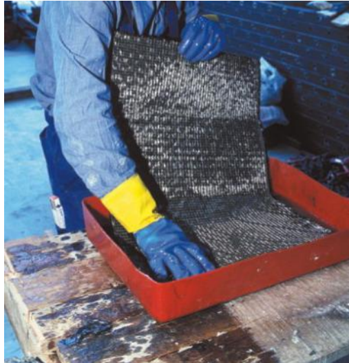
13. ábra Szénszálas szövet impregnálása kézzel
