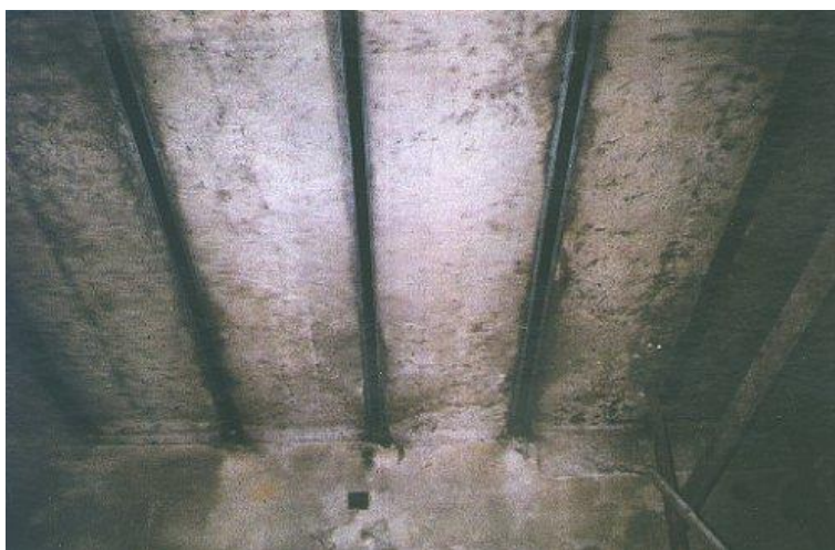
19. ábra A födém a megerősítés után
