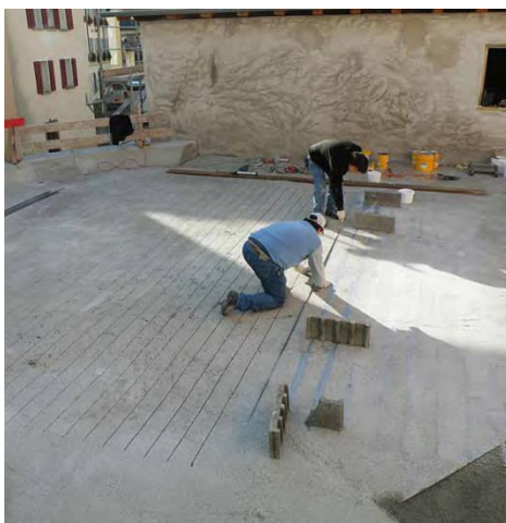
24. ábra A szálak behelyezése a résekbe
