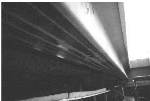
21. ábra A hídgerenda a megerősítés után
