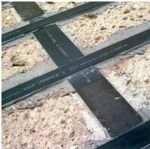
7. ábra Szénszálak lamella felhelyezés után
