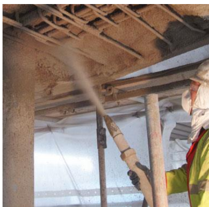
29. ábra Lőttbeton alkalmazása sérült vasbeton szerkezetről
