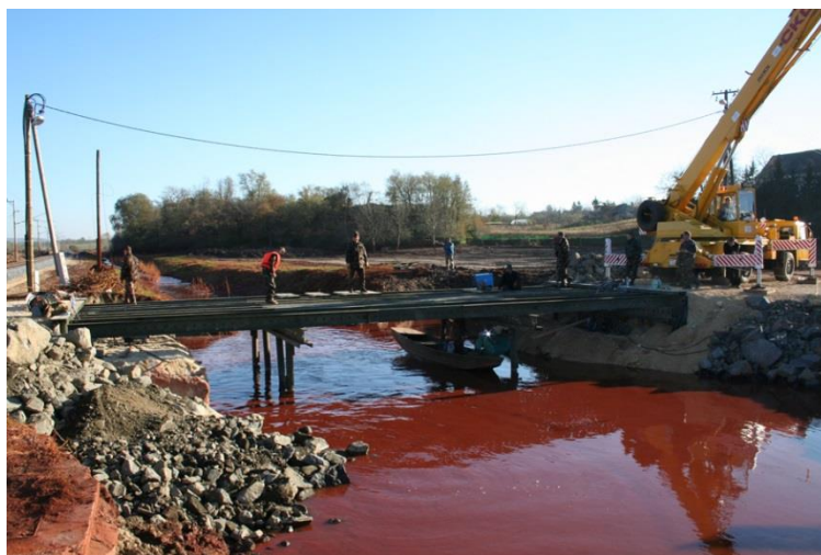
32. ábra Hídépítés a vörösiszap sújtotta Kolontáron
