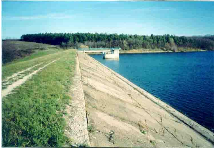
5. ábra: A völgyzárógát vízoldali része betonburkolattal, illetve a füvesített töltéskorona ( http://www.kdtvizig.hu/ )
