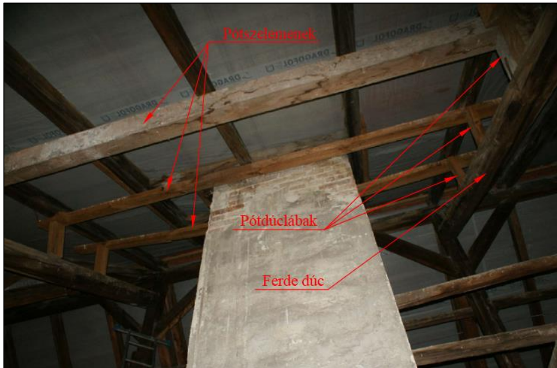
14. ábra: Az utólagos alátámasztások (pótszelemenek) elhelyezkedése az I. és II. főszaruállás között (a szerző felvétele)
