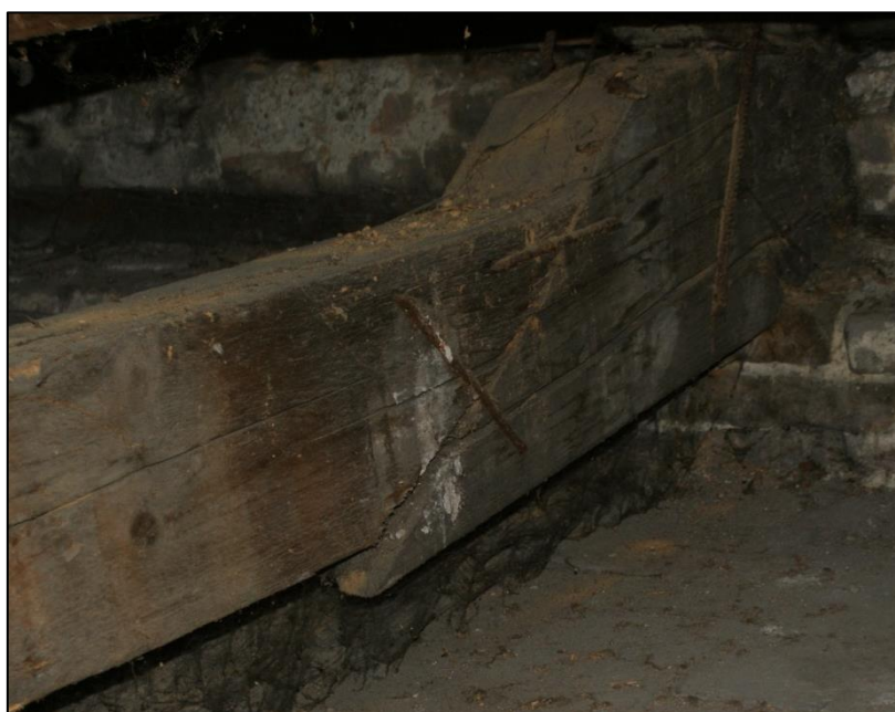
20. ábra: Az egyik kötőgerenda (kgIII.) szakszerűtlen toldása, látszik a ferde lapolás szétnyílása (a szerző felvétele)
