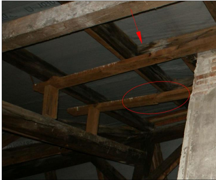
17. ábra: A psz1 jelű pótszelemen szálkifutásos tönkremenetele és a kk1 jelű elem beázás miatti foltosodása (a szerző felvétele)
