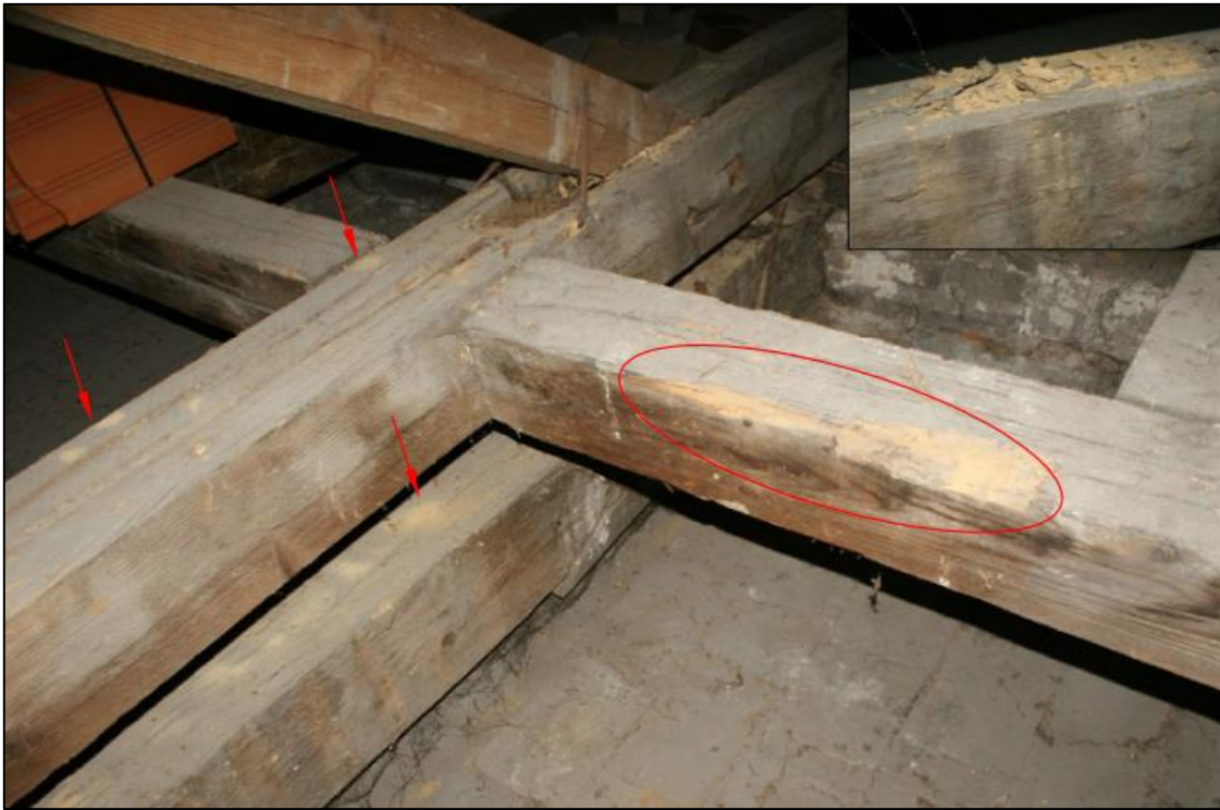
18. ábra: Házcincér ( Hylotrupes bajulus L.) károsítása a bekötőgerendákon, a fiókváltó gerendán és a kötőgerendán; a kgIII. elemen lévő károsítás árral megkapargatva (a szerző felvétele)
