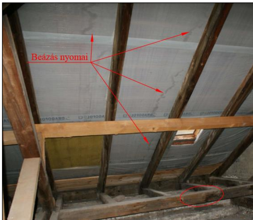
16. ábra: A vízzáró fólián a beázás nyomai láthatóak; a bekarikázott részen szintén beázás nyomai észlelhetők feltételezhetően a fölötté lévő kis ablak rossz zárása miatt (a szerző felvétele)
