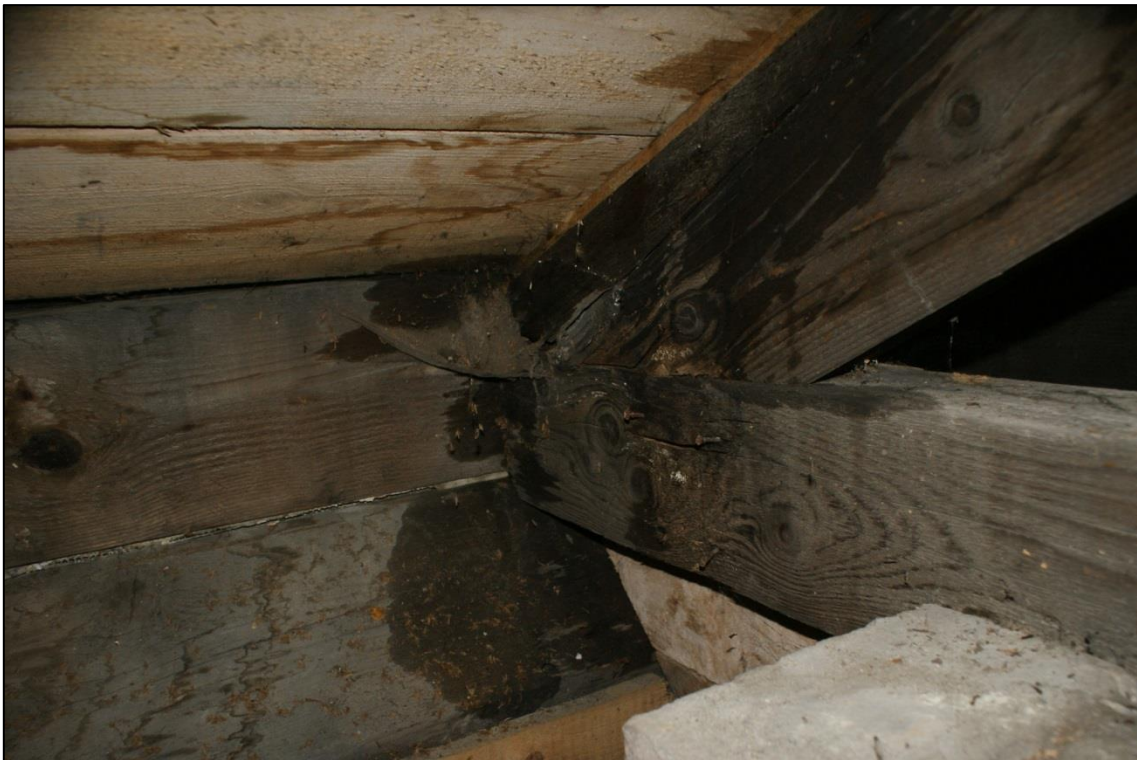
15. ábra: Erős beázás az I.d alsó jelű szarufa alsó végénél (a szerző felvétele)
