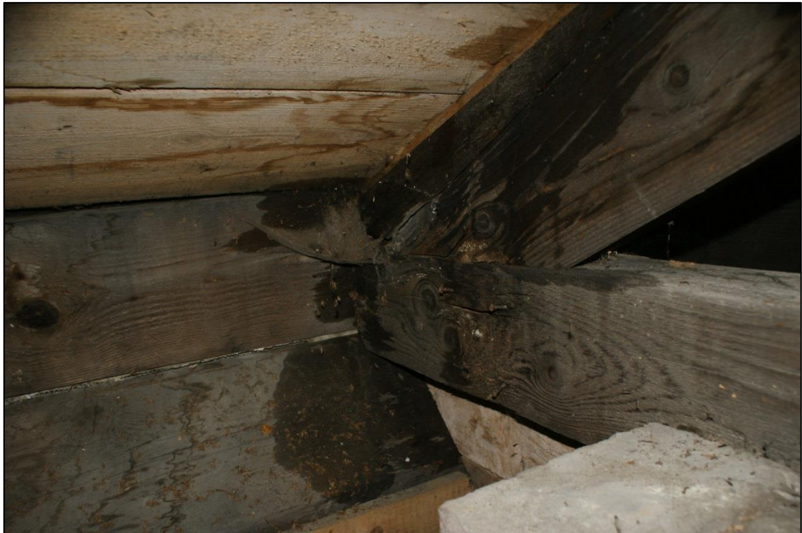
25. ábra: Erős beázás az I.d alsó jelű szarufa alsó végénél (a szerző felvétele)
