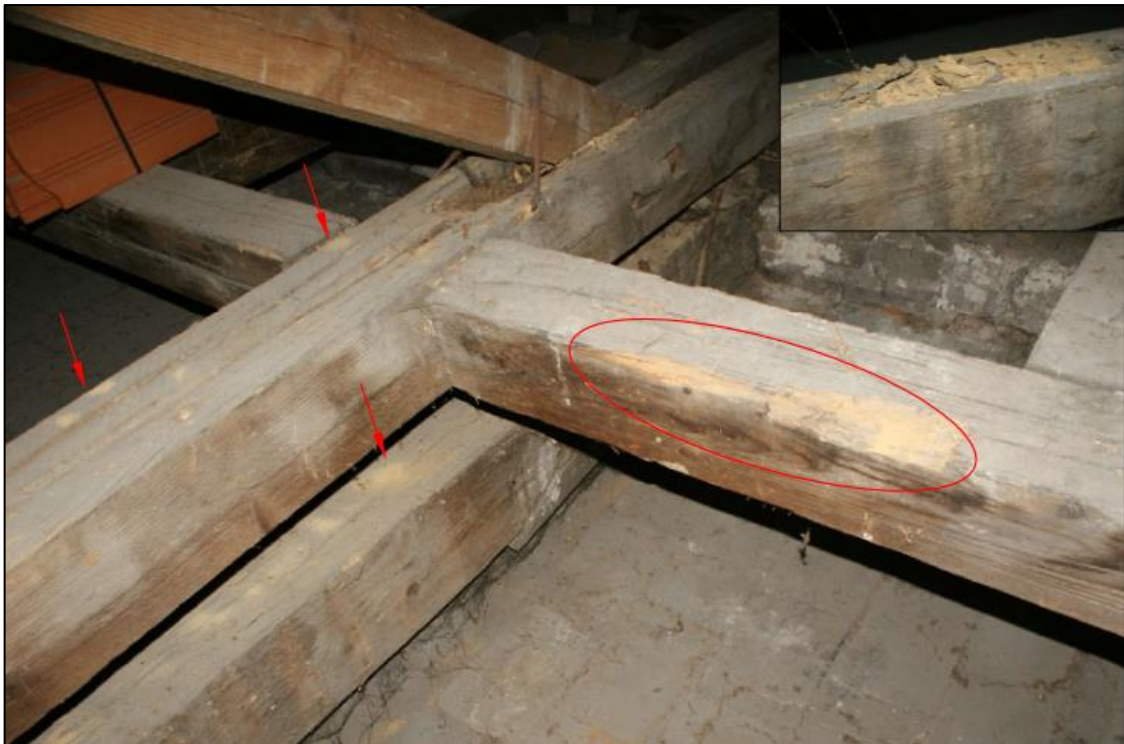
28. ábra: Házicincér ( Hylotrupes bajulus L.) károsítása a bekötőgerendákon, a fiókváltó gerendán és a kötőgerendán; a kgIII. elemen lévő károsítás árral megkapargatva (a szerző felvétele)
