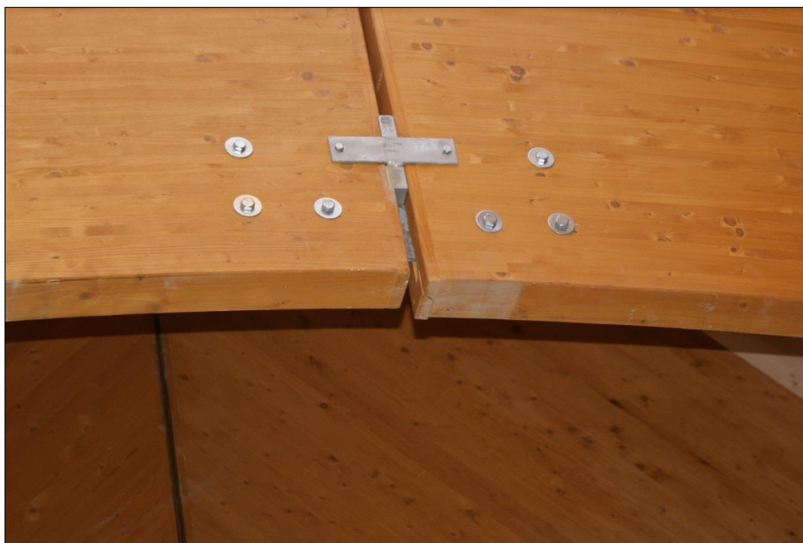
6. melléklet: A tartók lesüllyedése a középső síkban (a szerző felvétele)
