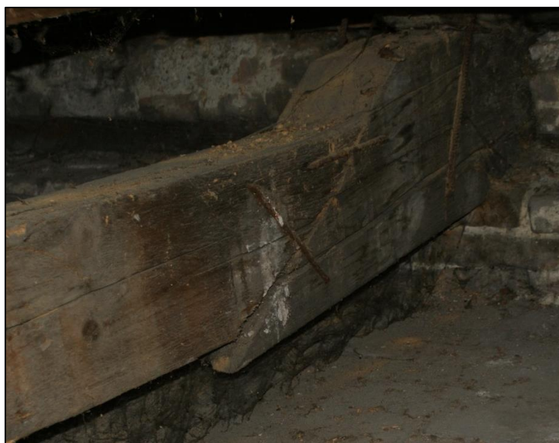
30. ábra: Az egyik kötőgerenda (kgIII.) szakszerűtlen toldása, látszik a ferde lapolás szétnyílása (a szerző felvétele)
