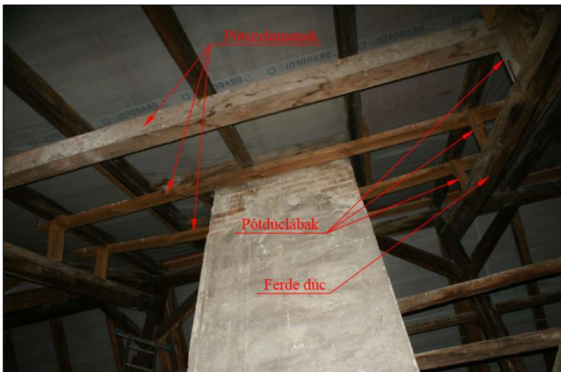
24. ábra: Az utólagos alátámasztások (pótszelemenek) elhelyezkedése az I. és II. főszaruállás között (a szerző felvétele)
