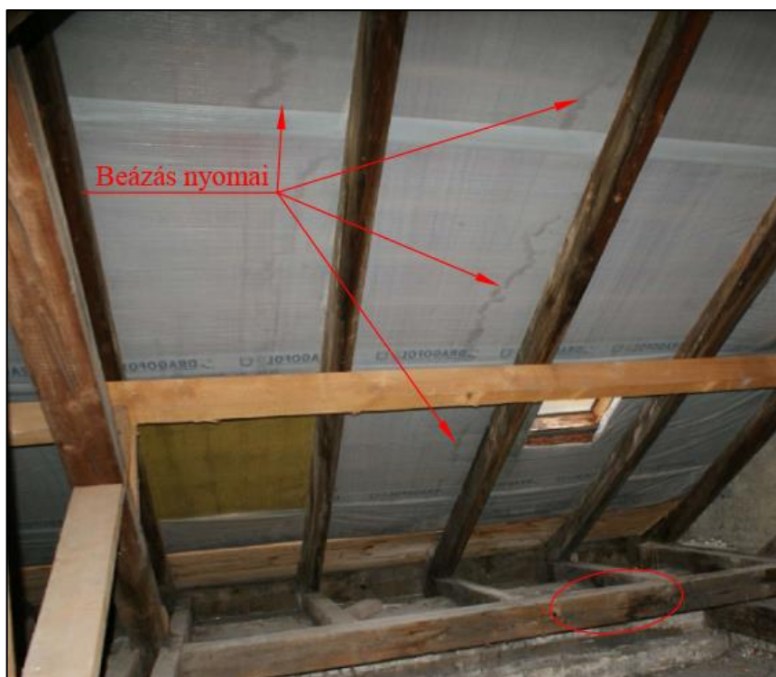
26. ábra: A vízzáró fólián a beázás nyomai láthatóak; a bekarikázott részen szintén beázás nyomai észlelhetők feltételezhetően a fölötte lévő kis ablak rossz zárása miatt (a szerző felvétele)
