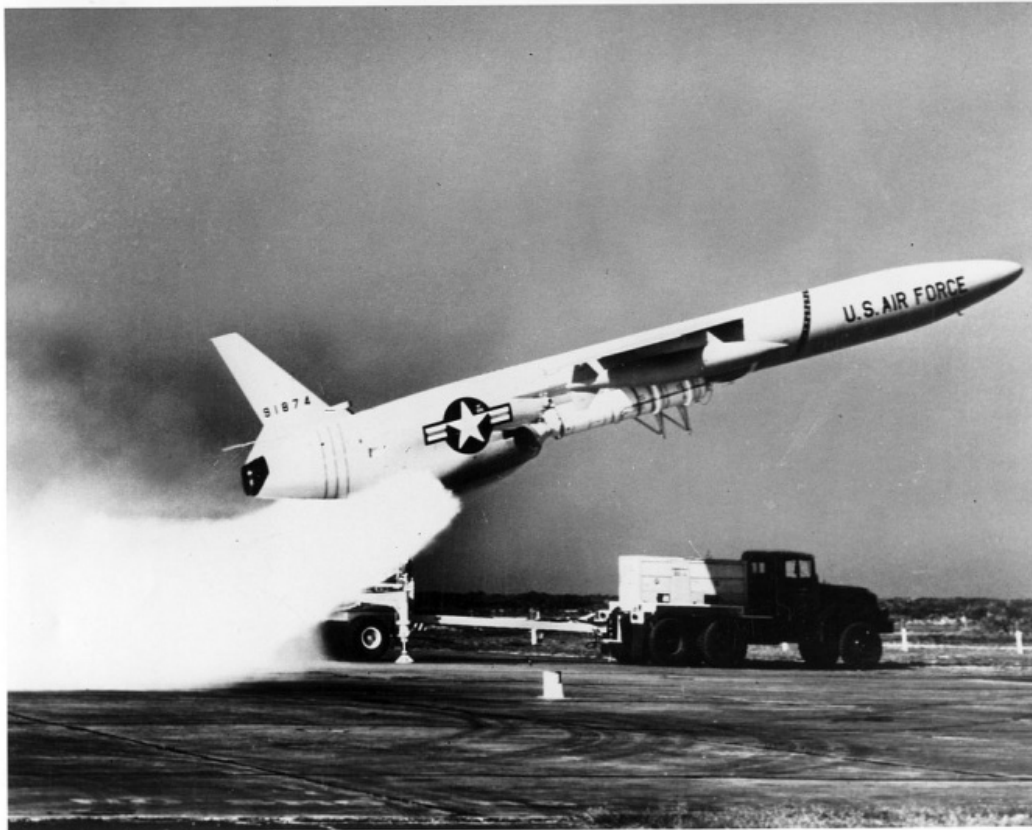
5. számú kép: A Snark oldalán jól látható a két gyorsító rakéta 18
