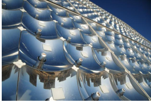
29. ábra: Fresnel lencse segítségével koncentrált fény vetítése a napelem cellára (CPV technológia)
