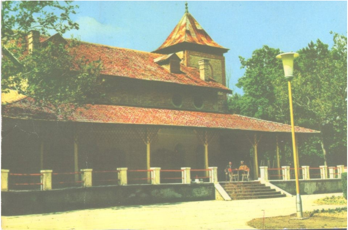
11. ábra: A Vigadó az erkély lebontása után
