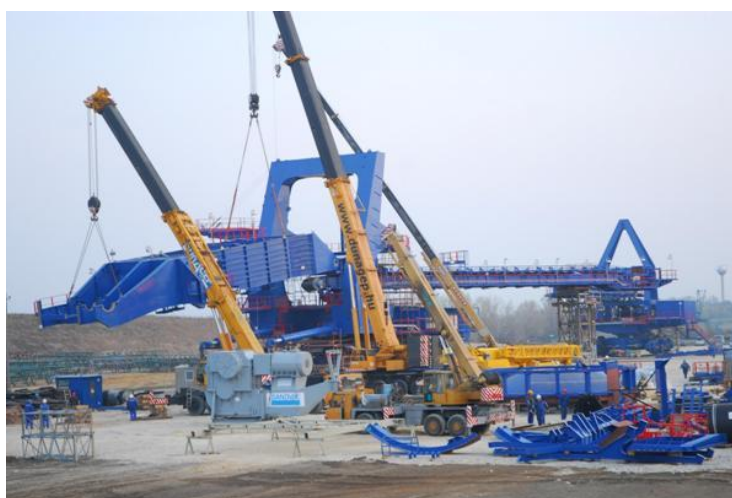
20. ábra Sandvik PE 100-as marókotró összeszerelése (2013.10.19.), Forrás: www.mert.hu [34]
