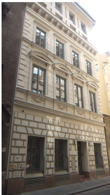
3. A Gerlóczy utcai műhely épülete jelenlegi állapotában (2014)
