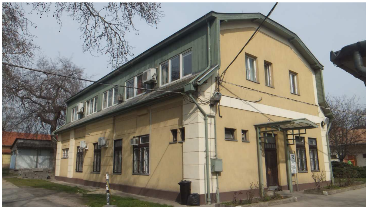
5. Az Uzsoki utcai üzem főépülete jelenlegi állapotában (2014)
