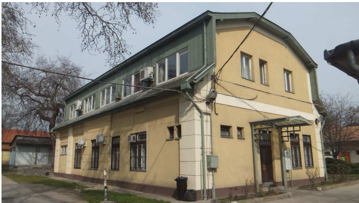
5. Az Uzsoki utcai üzem főépülete jelenlegi állapotában (2014)
