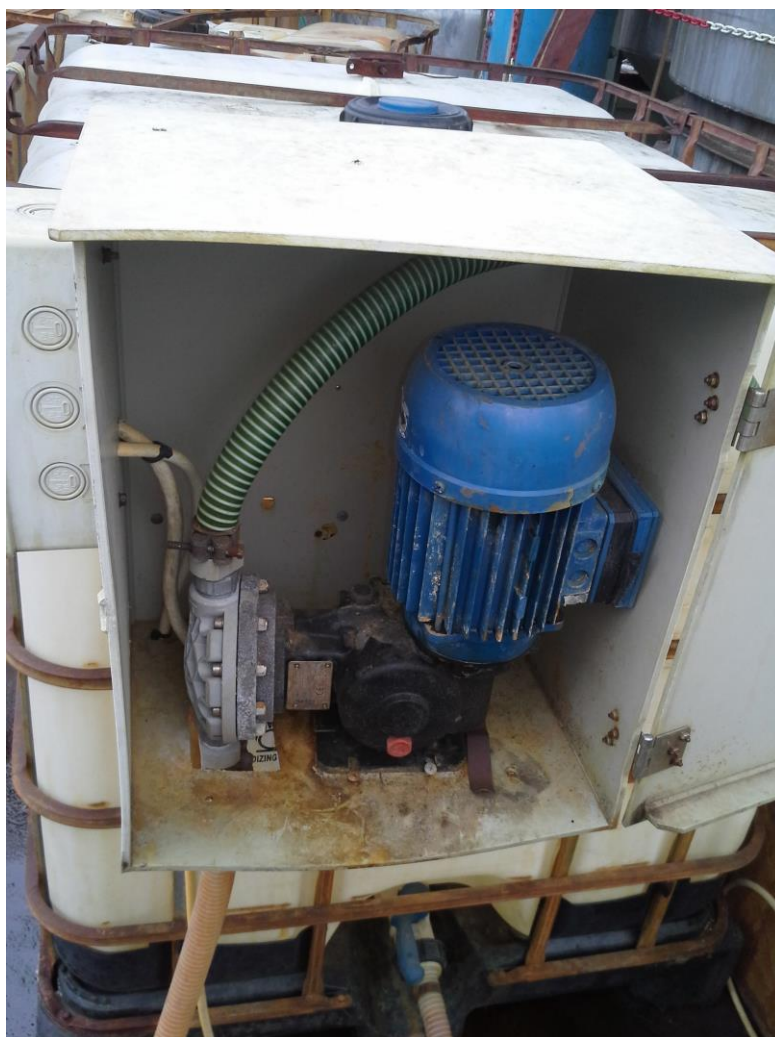
1. ábra Hidrogén-peroxid beadagolására szolgáló vegyszeradagoló
