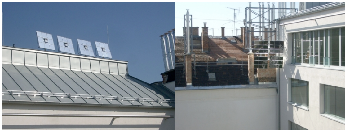
1. ábra Heliostat rendszer [1]
