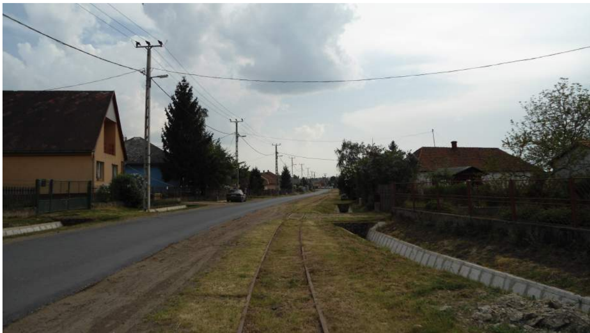
26. Ábra: Tiszaberceli falukép a kisvasúttal (saját fotó)
