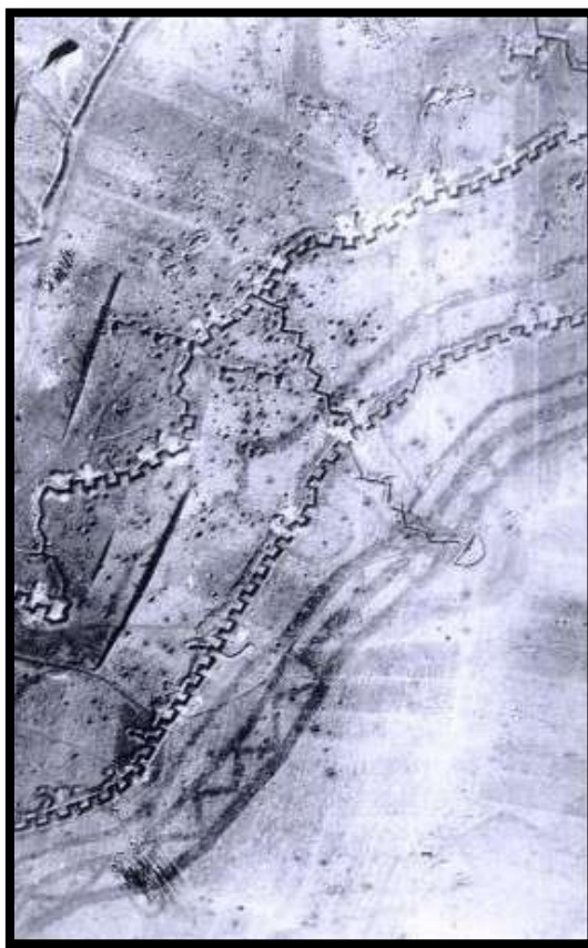
11. ábra: Harcárokrendszer Cambrai közelében 71
