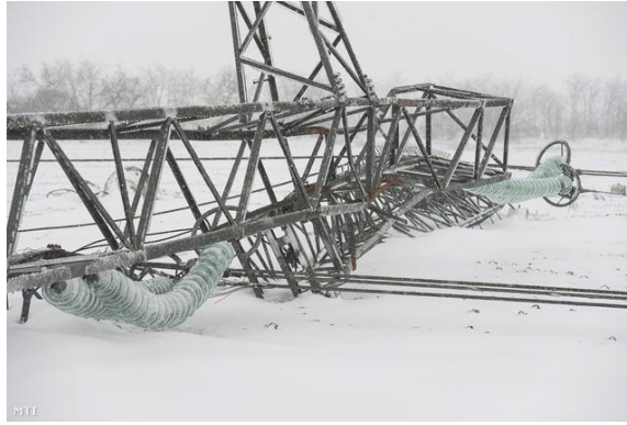
14. ábra Leszakadt fővezeték Kemece és Nagyhalász határában Fotó: Balázs Attila / MTI
