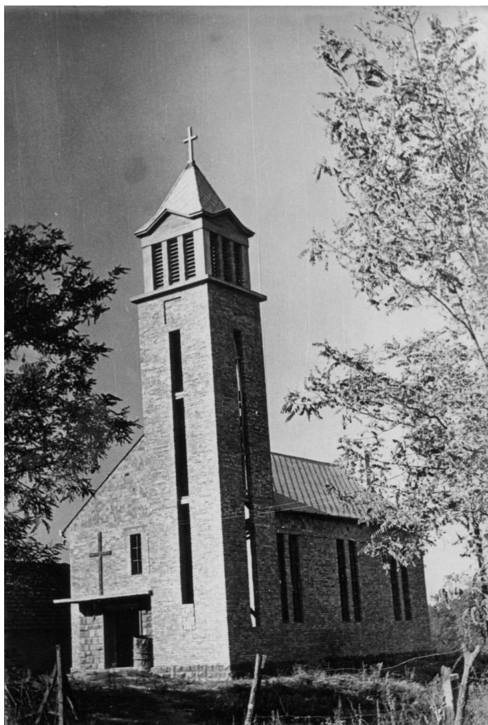
A ménfőcsanaki evangélikus templom építése 108
