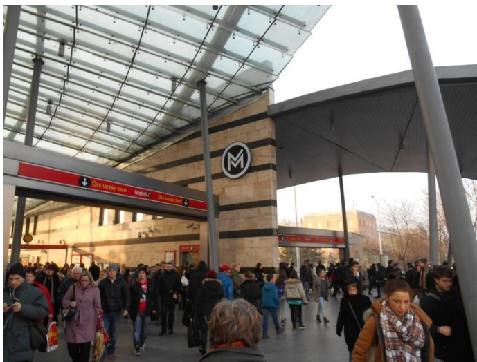
21. ábra Örs vezér tere állomás (Forrás: Saját fotó)
