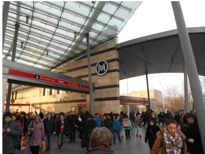
37. ábra Örs vezér tere állomás (Forrás: Saját fotó)
