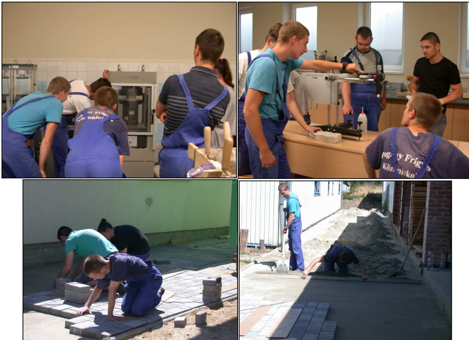
62. ábra: Gyártott térkő minőségellenőrzése, térkő lerakása[Saját forrás.]
