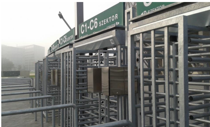
6. A Groupama Aréna biometrikus beléptető kapui (forrás: saját fényképfelvétel)
