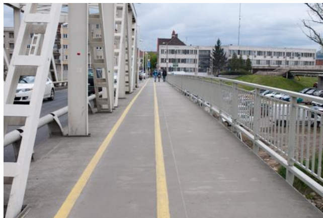
16. ábra Petőfi híd
