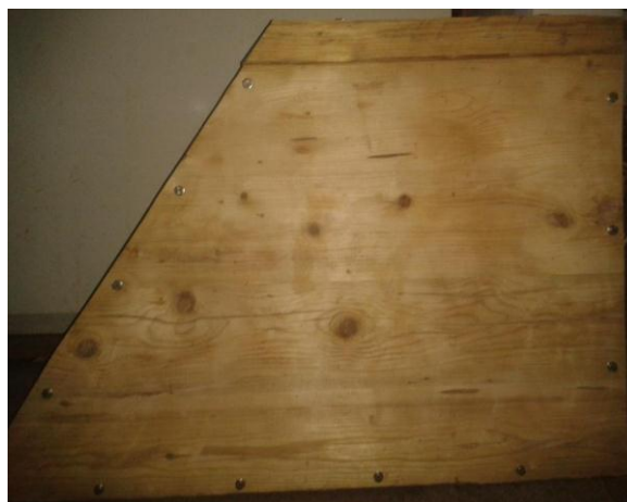
7. ábra: Alkalmazott háromrétegű zsaluhéj
