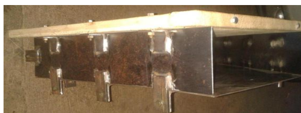
10. ábra: Alkalmazott fém és háromrétegű zsaluhéj rögzítése
