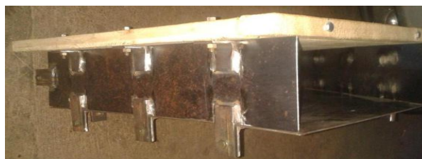
10. ábra: Alkalmazott fém és háromrétegű zsaluhéj rögzítése
