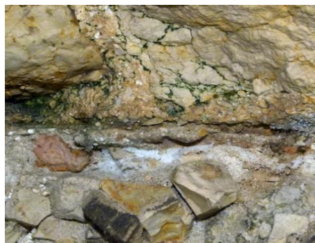
A kiomlás alatti habarcsváltás
