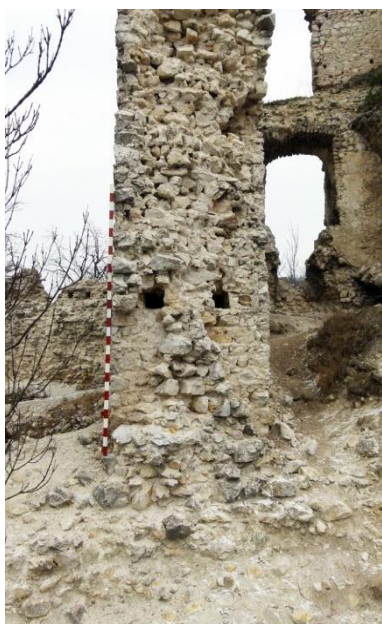
A torony déli végén lévő falelálás a gerendafészekkel
