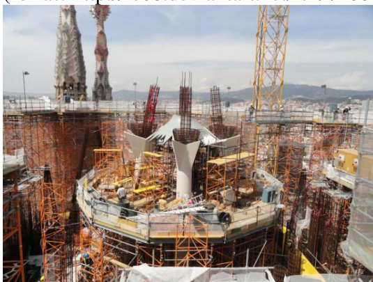
5.kép: A Jézus torony építés közben
