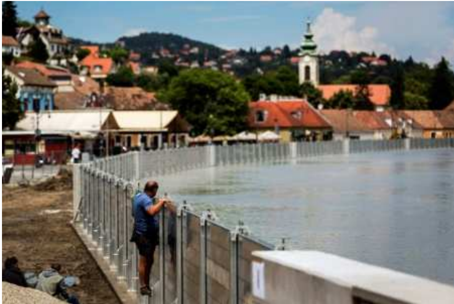
8. ábra: A Szentendrét a Duna áradásától védő mobil árvízvédelmi fal Szentendrén 2013. június 3-án (FOTÓ: MTI/KOVÁCS ATTILA)
