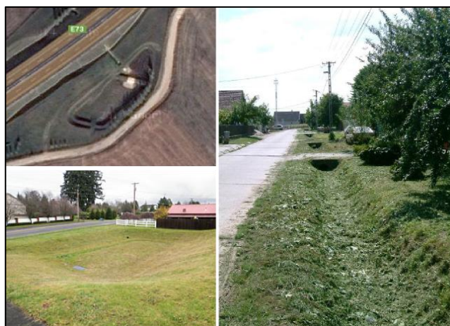
5. ábra Telepítés szikkasztóárkba vagy szikkasztótározóba
