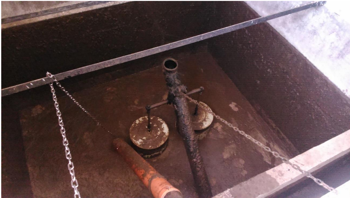
10. kép: Sűrítő átalakított bevezetéssel
