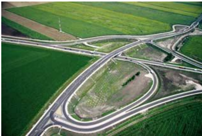
2. ábra Részben külön szintű (rávezető) csomópont 1. 9
