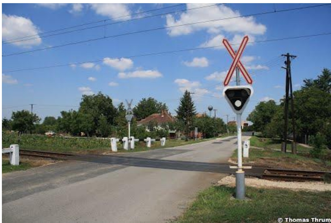
28. ábra Csak fénsorompóval biztosított vasúti kereszteződés 49
