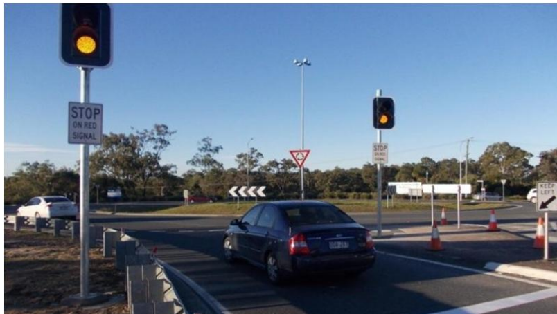
19. ábra Indirekt irányítású jelzőlámpával szabályozott körforgalom 2. 34
