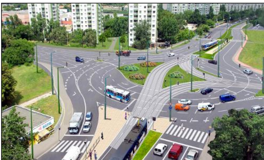
12. ábra Példa turbina-elv szerint működő csomópontra, Szeged [40]
