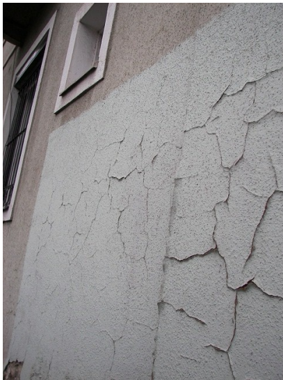
9. ábra: Nem megfelelő javítás [fotó: tulajdonostól]
