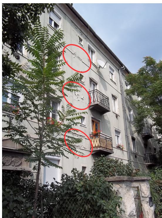
5. ábra: Átvizesedés jelei [saját fotó]
