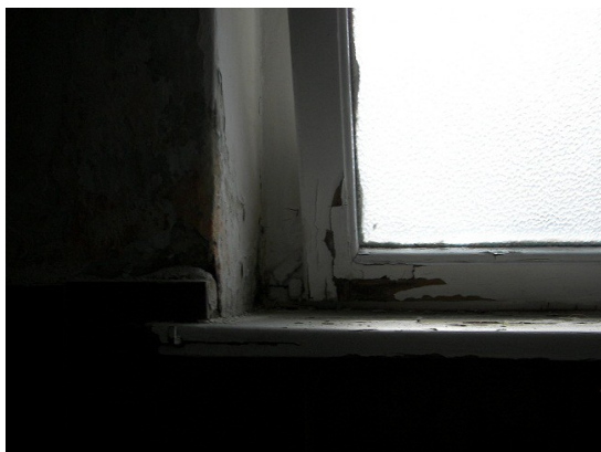
7. ábra: Nyílászáró szerkezetének károsodása [fotó: tulajdonostól]
