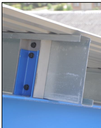
26. ábra Szelemenbakok elhelyezése
